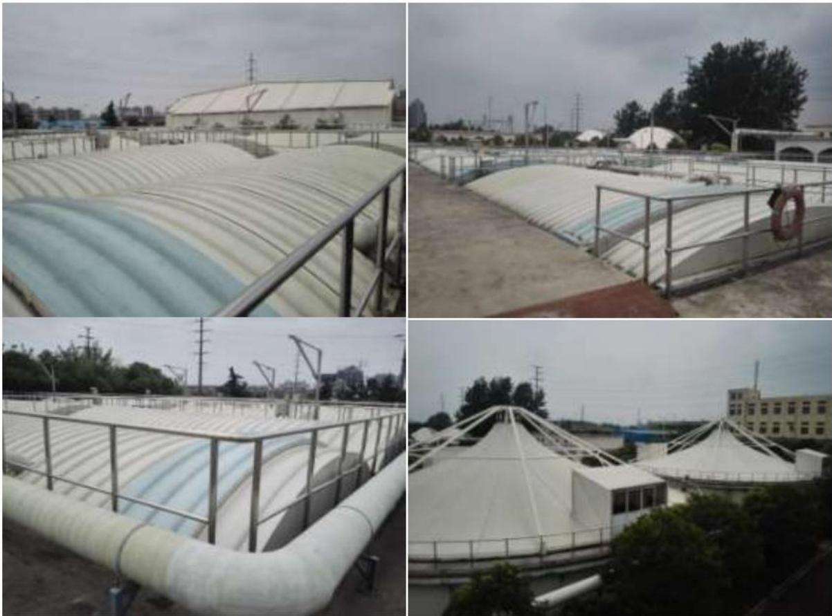
图 6.1.1-1 同类型污水处理厂装置密封效果图
